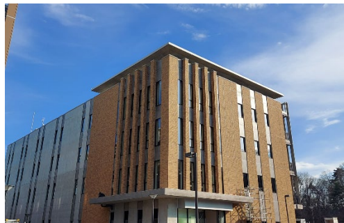
青葉山ユニバース（2024 年 3 月竣工予定）
