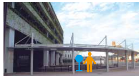
バスのりばには屋根を設置
